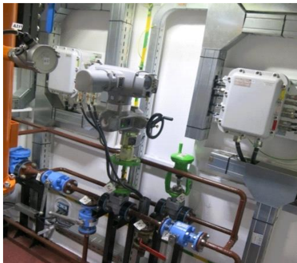
Рисунок 2 — Узел регулирования на базе клапана РУСТ 400 с приводом АУМА
