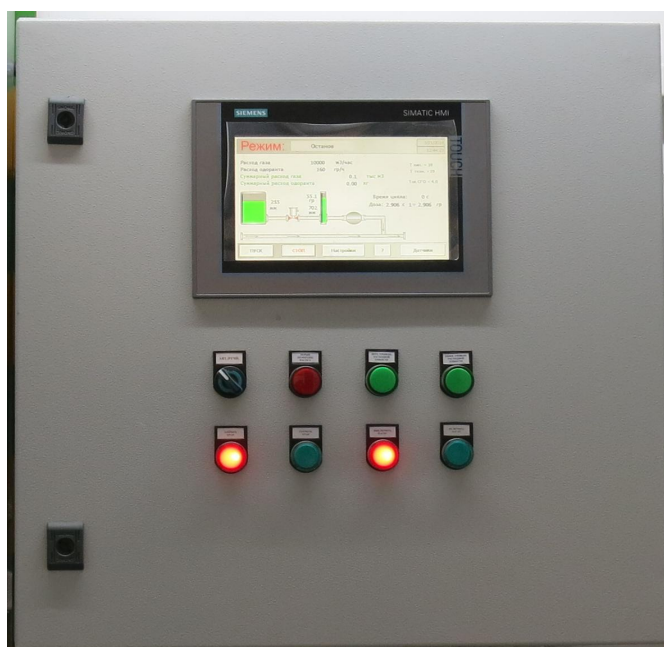
Рисунок 3. Блок управления одоризатором БУО
