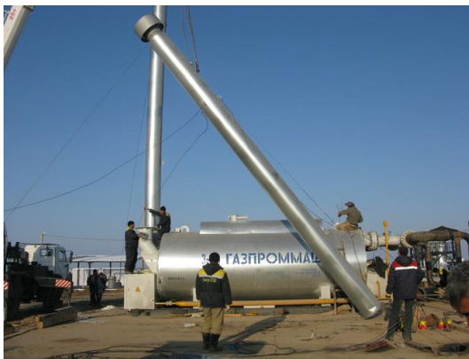
Монтаж ГПМ-ПТПГ-100 на объекте (Казахстан)
