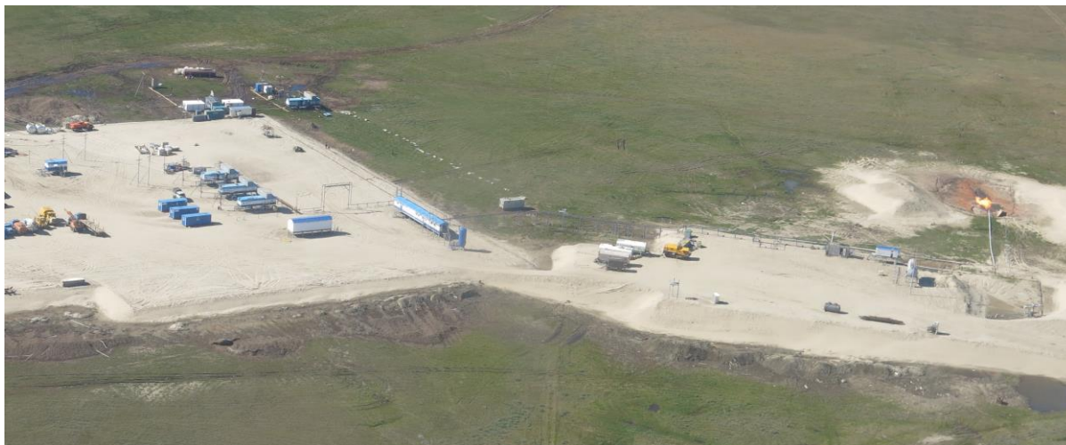
Общий вид скважинной площадки с блоком подготовки газа завода «Газпроммаш»
