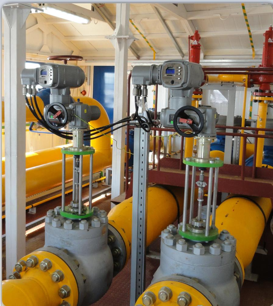
*Позиционируемые регуляторы давления газа*
