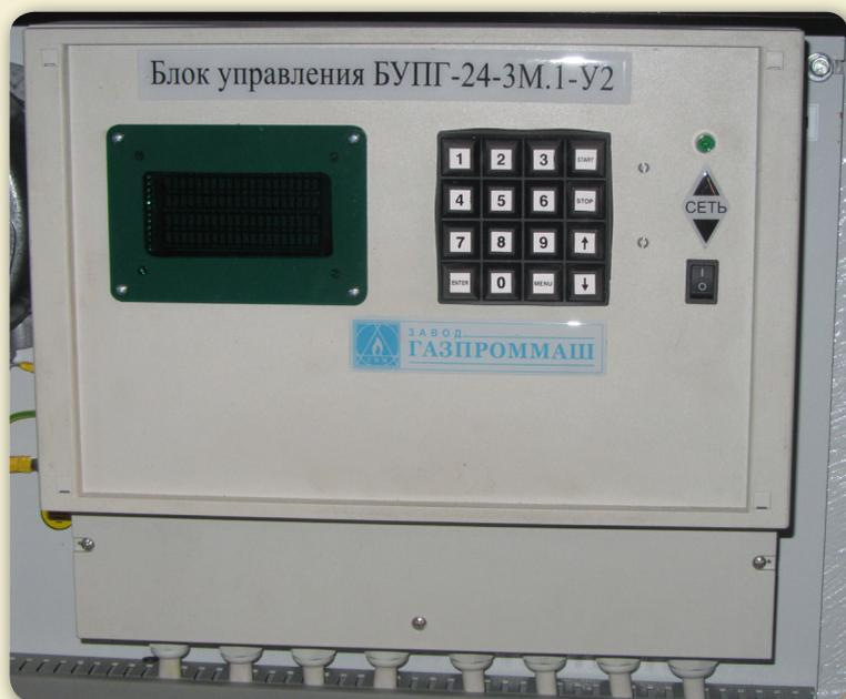
*Передняя панель блока управления подогревателем газа
