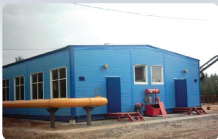
ГРПБ на объекте (г. Сургут)
