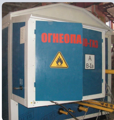
Рисунок 1. Одоризатор газа навесного типа для малопроизводительных ГРС
