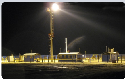
ГРС ГАЗПРОММАШ на объекте (Калмыкия)
