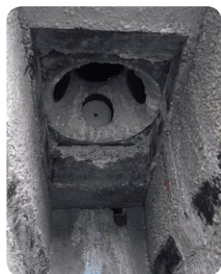
Футеровка из жаропрочного бетона
