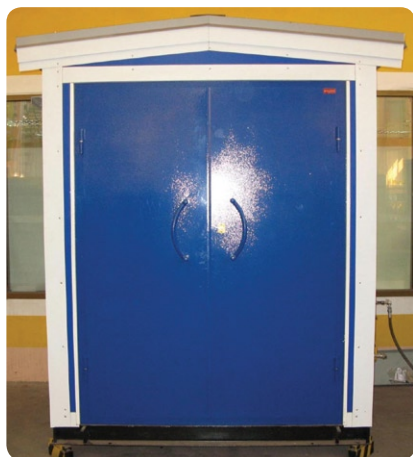
Рисунок 2. Одоризатор газа с односторонним обслуживанием.
