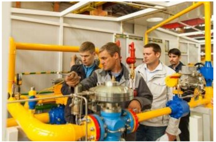
*Проверка настройки регулятора давления газа*
