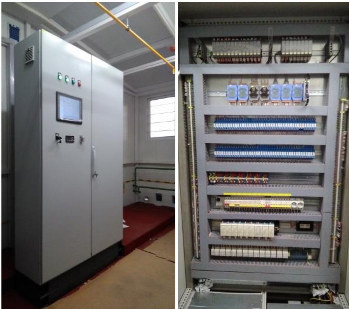
ШКУ БПГ на базе ПЛК «ОРИОН»
