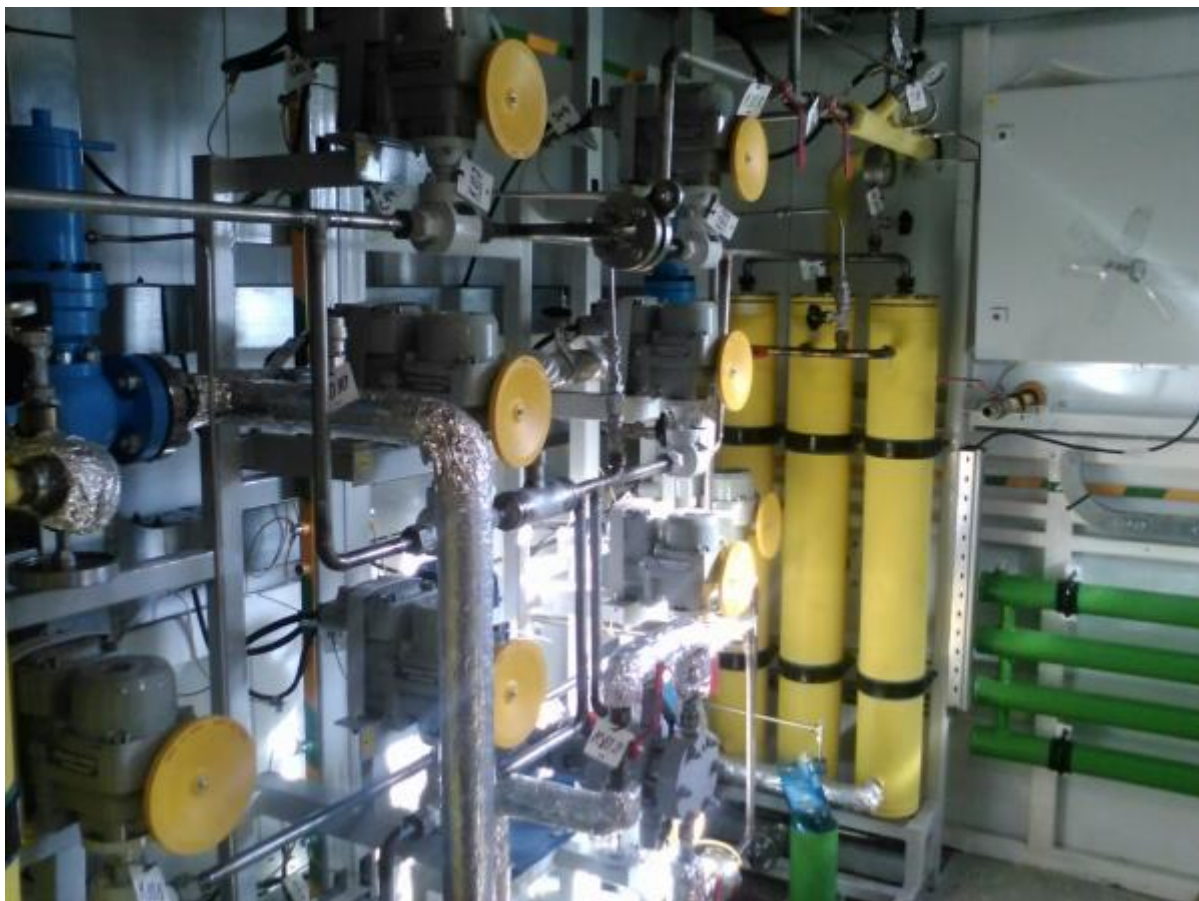
Рисунок 3. Блок подготовки импульсного газа ГПМ-БПИГ-500/6,3.
