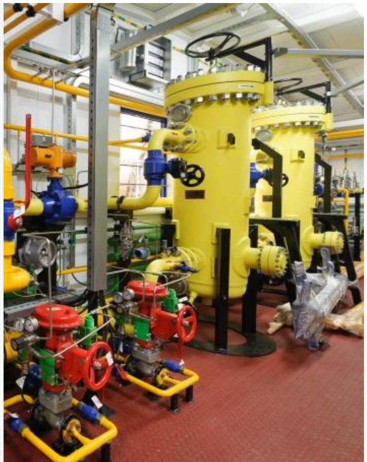
ГПМ-ФКО-80/100 из хладостойкой стали со сливом жидкости в накопитель
