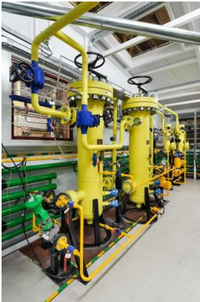
ГПМ-ФКО-50/100 из хладостойкой стали с автоматическим сливом жидкости
