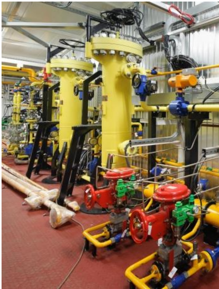
ГПМ-ФКО-50/100 из коррозионно-стойкой стали со сливом жидкости в накопитель
