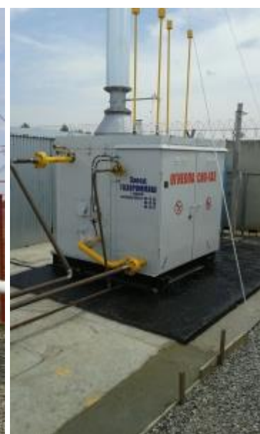
Примеры выполнения ремонта с использованием подогревателей газа ГПМ-ПГА
