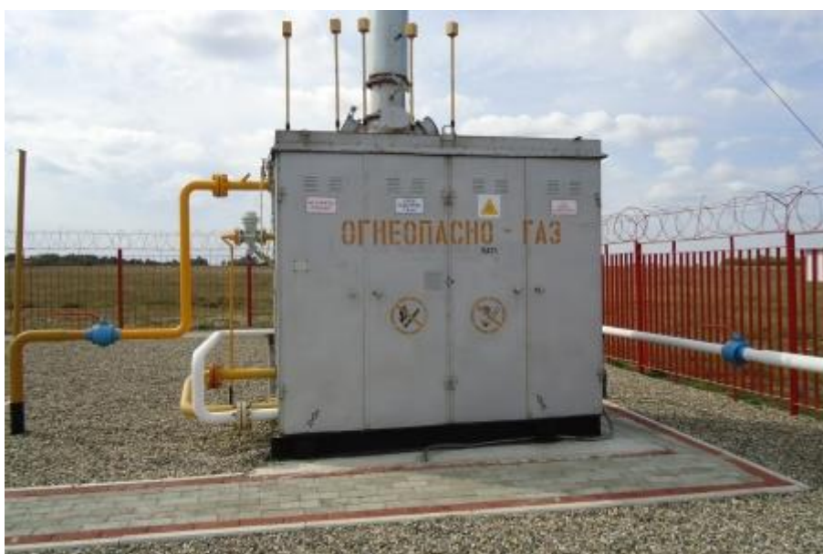
Примеры выполнения ремонта с использованием подогревателей газа ГПМ-ПГА
