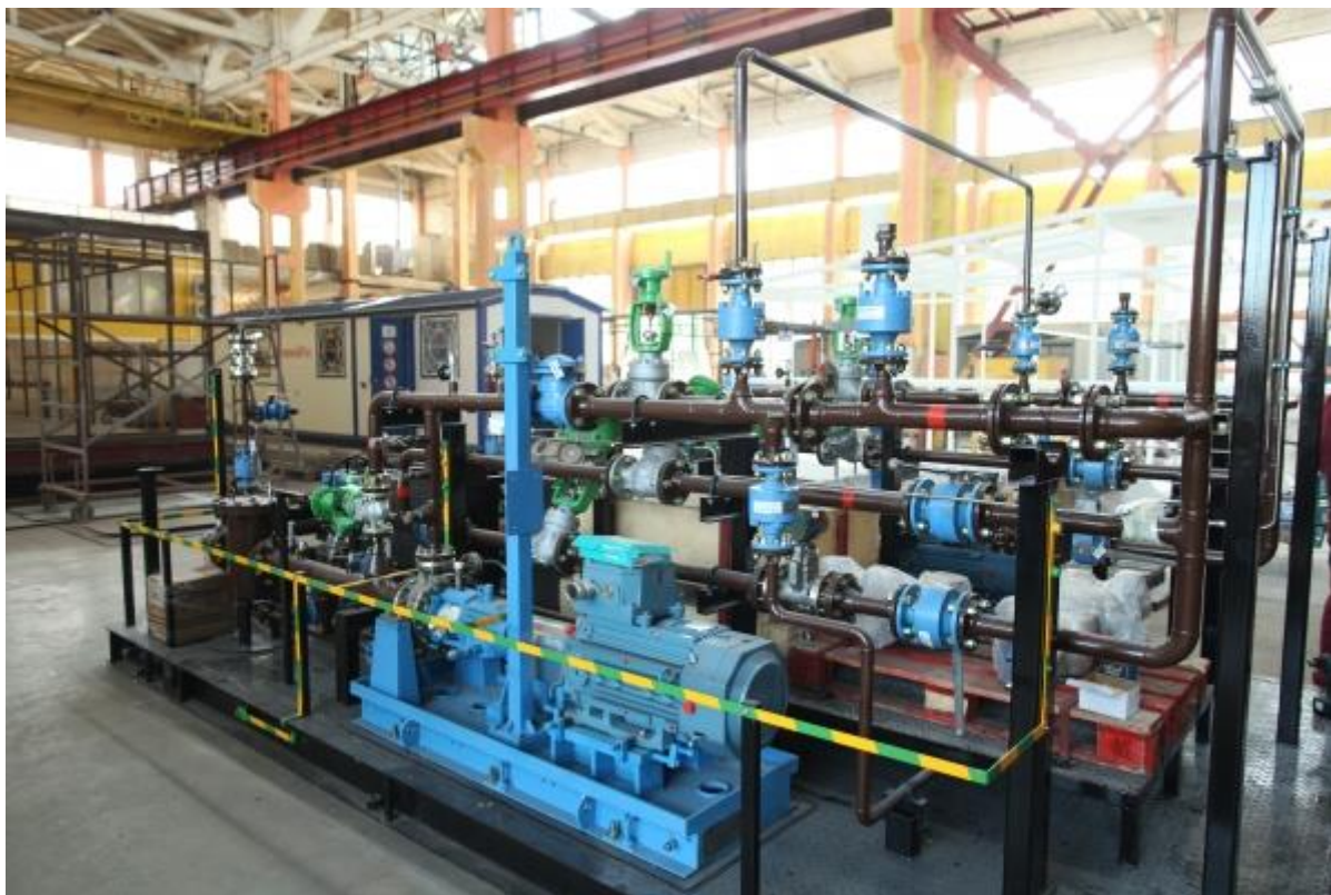
Идет сборка насосной станции перекачки ВМР для объекта ОАО «Ямал СПГ»
